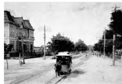
① 1912年(明治45年)の北3西3の風景 札幌停車場(札幌駅前)通を行く馬車鉄道
