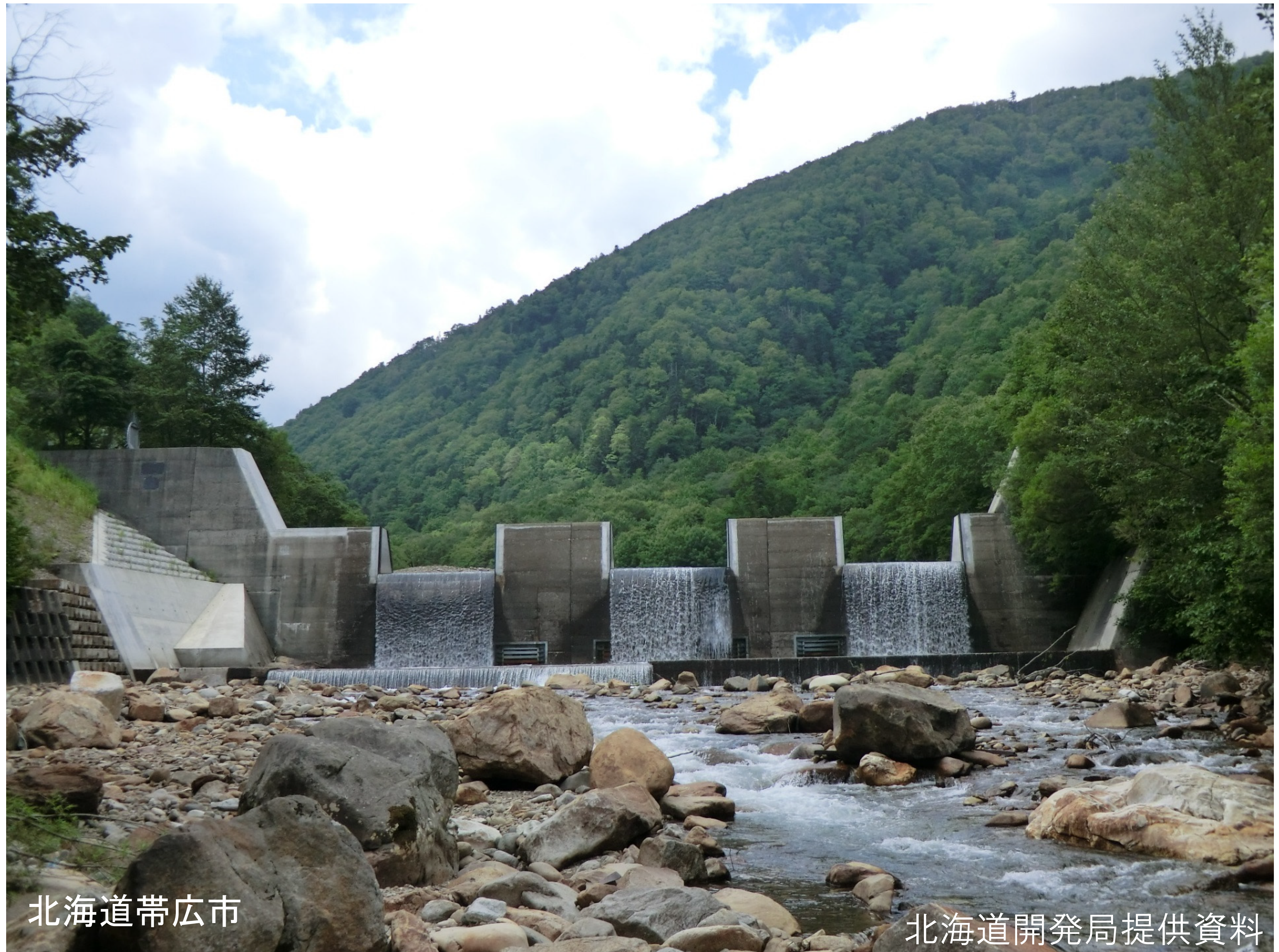
自然災害からくらしを守る施設の写真(砂防ダム)
