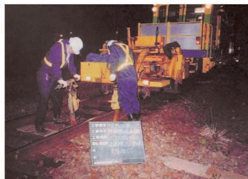
迂回路となった線路の補強工事
