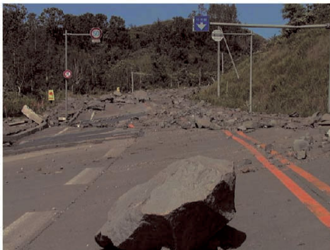
国道230号上の噴石（虻田町泉地区）
