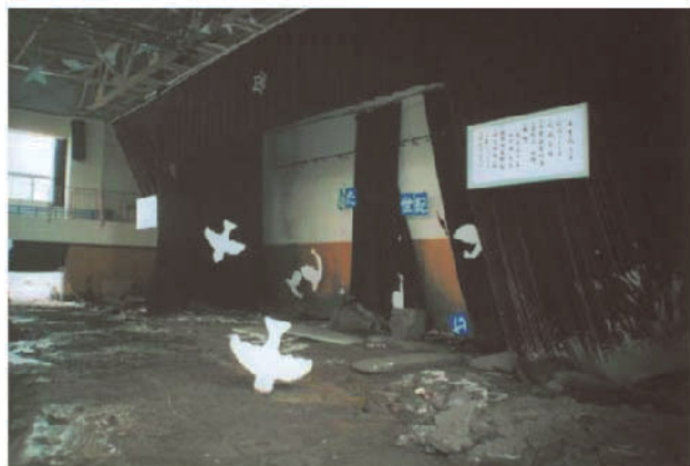
2000年噴火で被害を受けた洞爺湖温泉小学校
