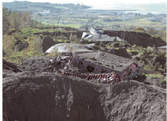
2000年有珠山噴火により破壊されたお菓子工場
