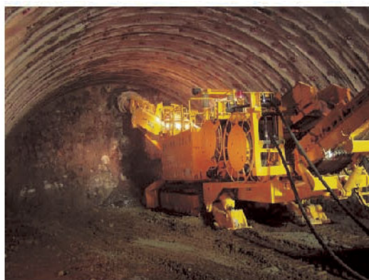
(仮称) 三豊トンネルの工事
