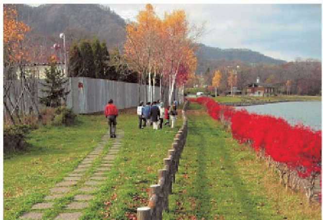
湖岸の柵。人が集まっているあたりで、並びが曲がり、手前（温泉側）が湖へせり出している。
