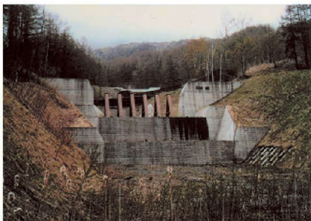
1977～1978噴火後につくられたスリットダム。流れてくる大きな岩石を止めます。
