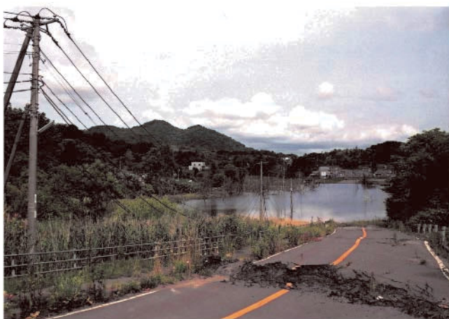
地面が圧縮されたためアスファルトが盛り上がり、電線がたるんだ
