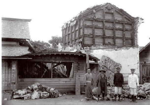
地震によって被害を受けた土蔵
