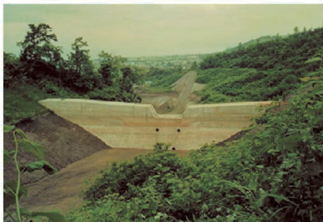
1977～1978噴火後につくられた砂防えんてい（ダム）。泥流や土石流を止めます。
