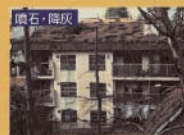
噴石・降灰 火口から放出された噴石や火山灰による建物への被害(2000年噴火)
