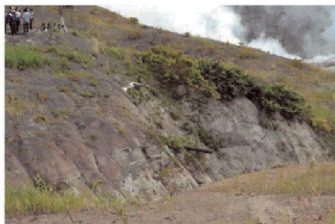
火口壁から突き出した上水道の配管
