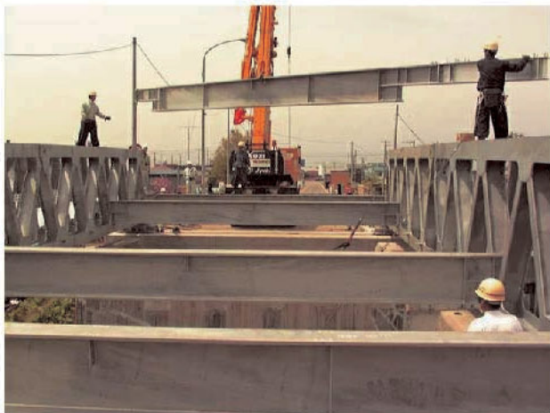
入江跨線橋の復旧工事
